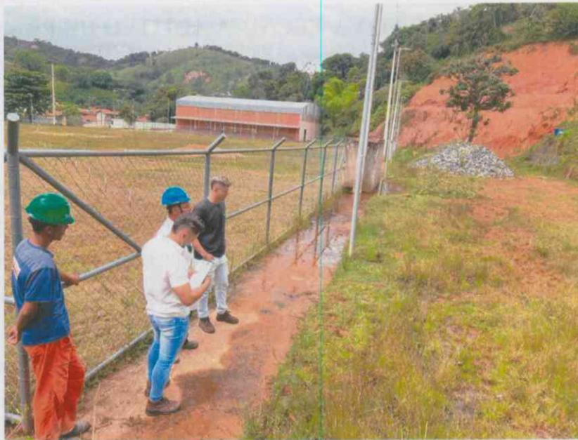
Imagem 1 – Vistoria técnica realizada, canaleta existente totalmente assoreada.
